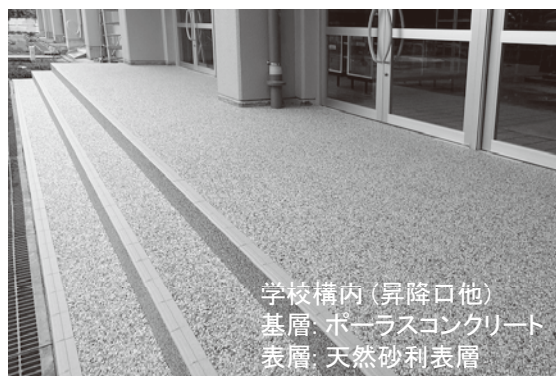
水は、路面下で水平方向に移動(排水)する
